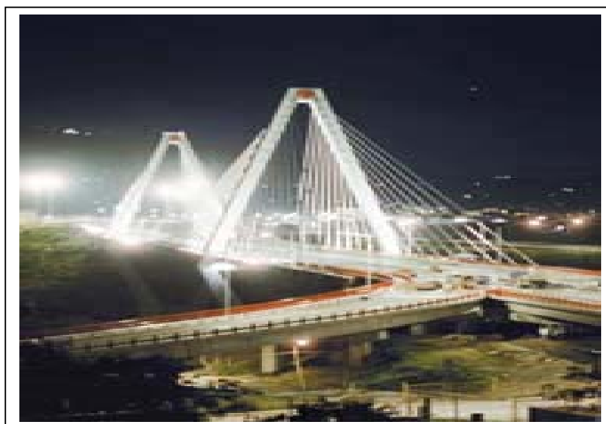
“VIADUCTO CESAR GAVIRIA TRUJILLO”
