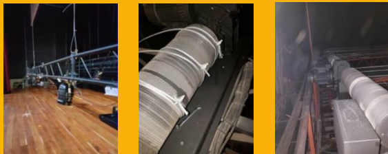
Desmonte de barra de iluminación y cambio de cables de acero
