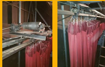
Revisión del motor del telón de boca e instalación de las rodachinas faltantes del sistema
